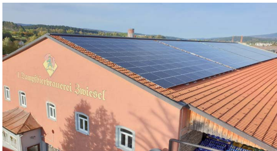
Abb. 4 Die neue Photovoltaikanlage (2020)
